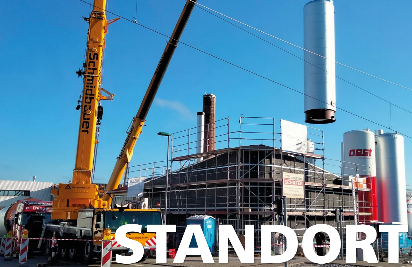
Vollsperrung der Straße für die Anlieferung und Aufstellung der neuen Tanks.
