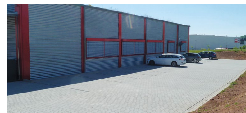
Die neuen zusätzlichen Parkplätze auf der Ostseite des Gebäudes.
